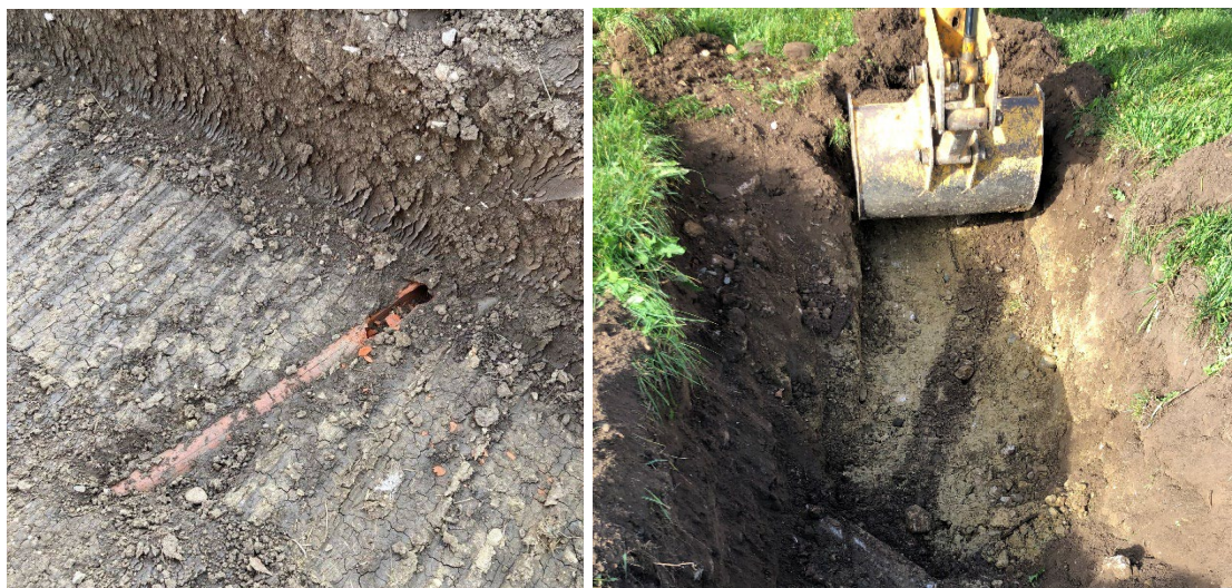
Sondage ; utiliser un godet sans dents pour voir le mélange de terres sur le drain ou le collecteur
